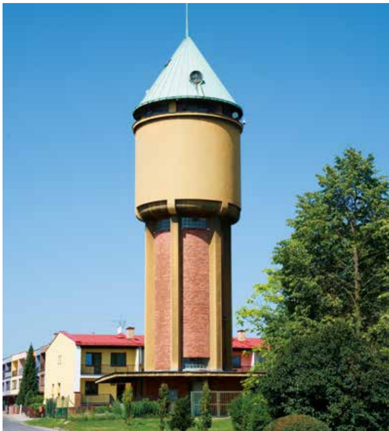
Obr. 5. Věžový vodojem podle návrhu architekta Františka Jandy (2019) Fig. 5. Elevated water tank designed by architect František Janda (2019)
