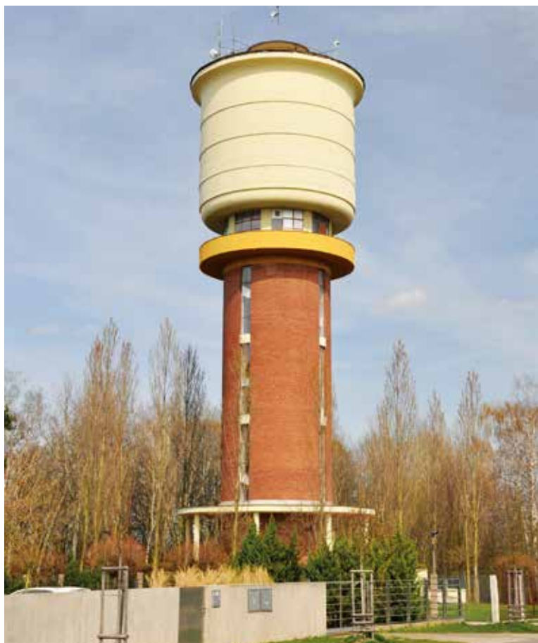
Obr. 3. Věžový vodojem pro Nový Hradec Králové (2015) Fig. 3. Elevated water tank for Nový Hradec Králové (2015)
