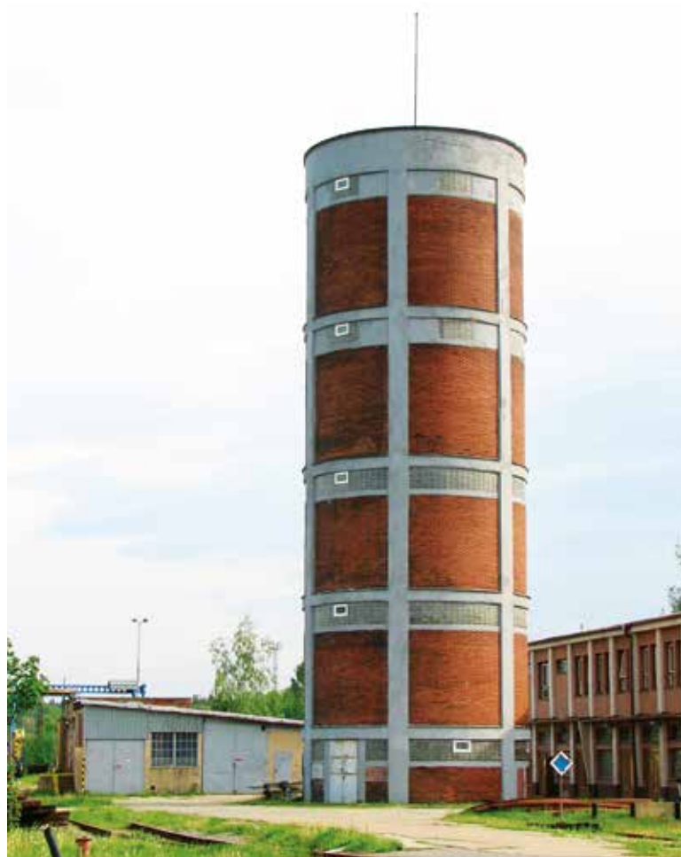
Obr. 2. Realizovaný věžový vodojem pro seřadovací nádraží (2012)
